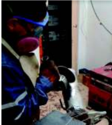
Figura 2.9. Limpieza de la soldadura con grata.
