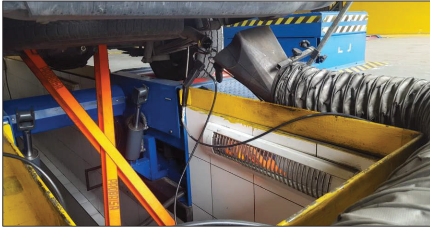
Figura 2. 11. Posicionamiento del extractor de gases.
