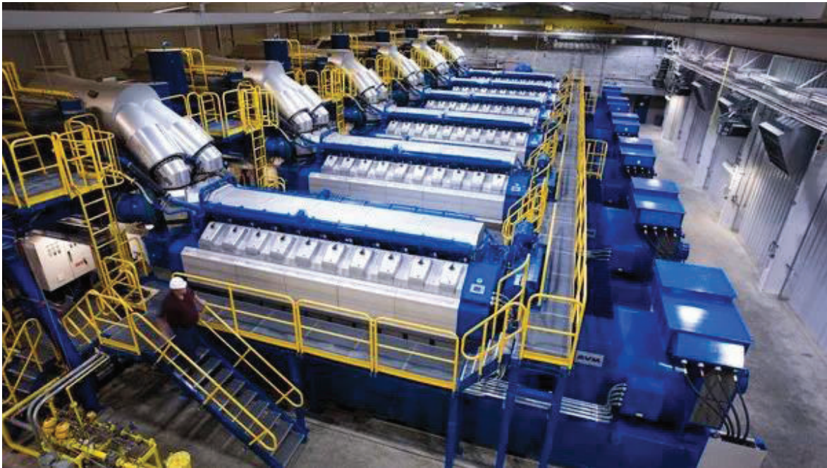
Figura 2.2 Motores alternativos de combustión interna para la industria. [8]
