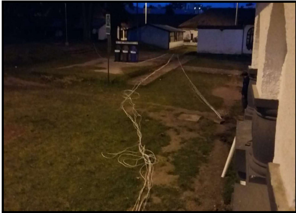
FIGURA 3.18 Envío del cable por el ducto subterráneo
