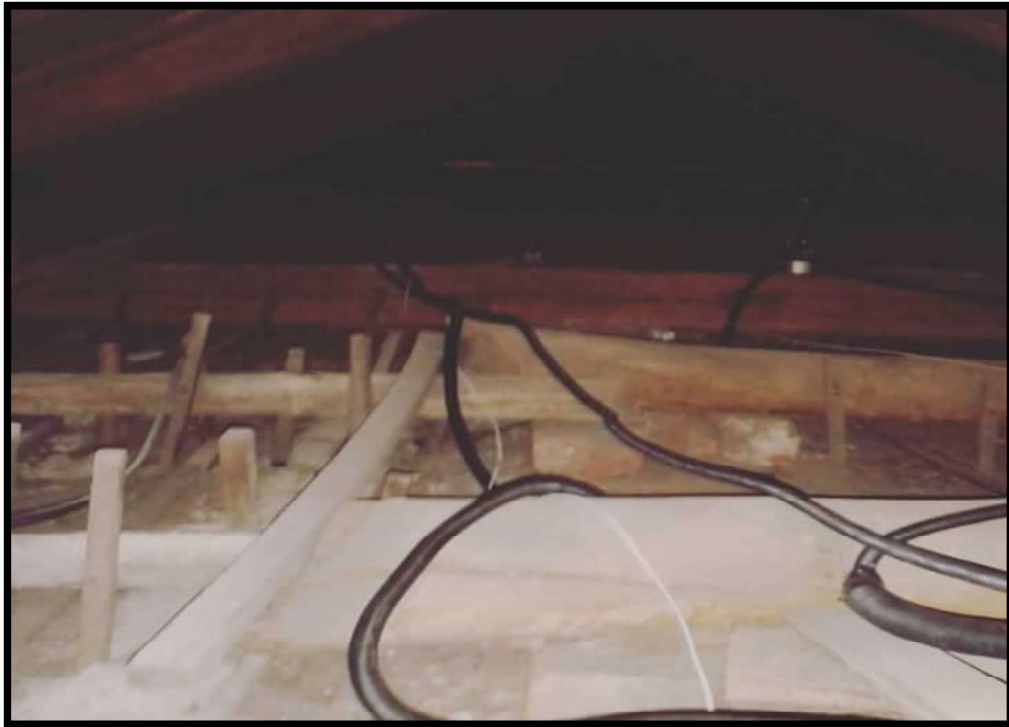
FIGURA 3.17 Tendido del cable por los techos de los pasillos
