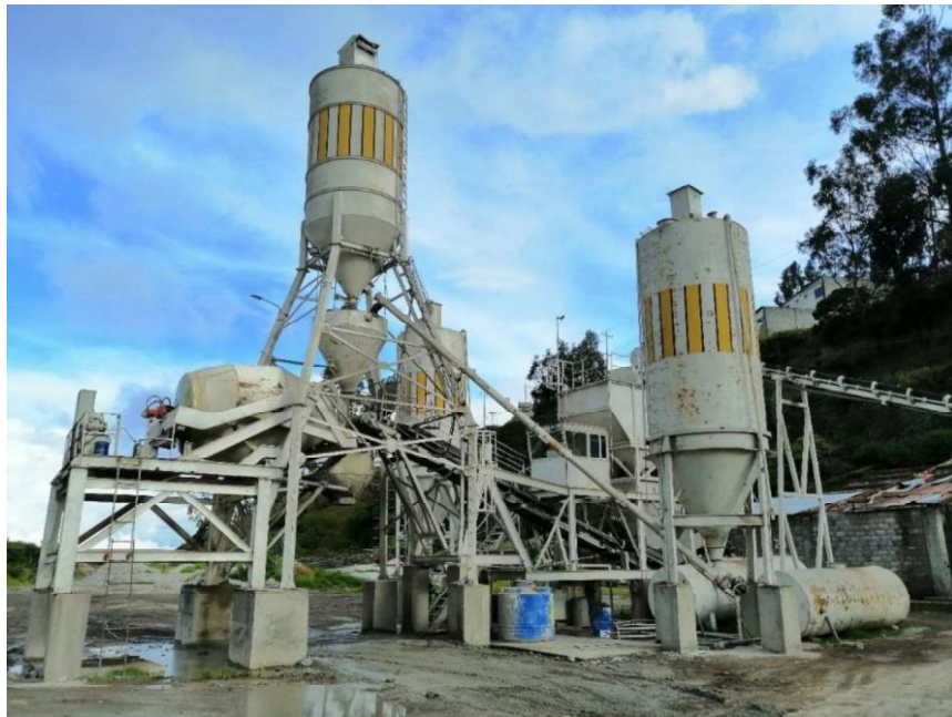
Figura 1.1. Planta de hormigón premezclado. (Fuente: Propia)
