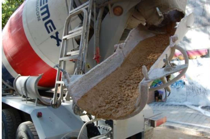
Figura 1.2. Colocación de hormigón. (Fuente: https://www.pavi-impreso.es/blog/pavimento-con-hormigon-coloreado/ )
