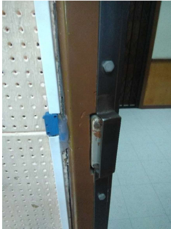
Figura 2.59. Interruptor para abrir la cerradura internamente.
