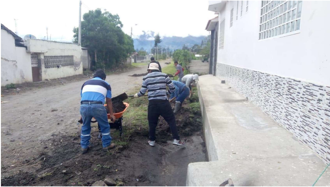
Figura 4 - Minka. Limpieza de conductos de agua Elaboración propia
