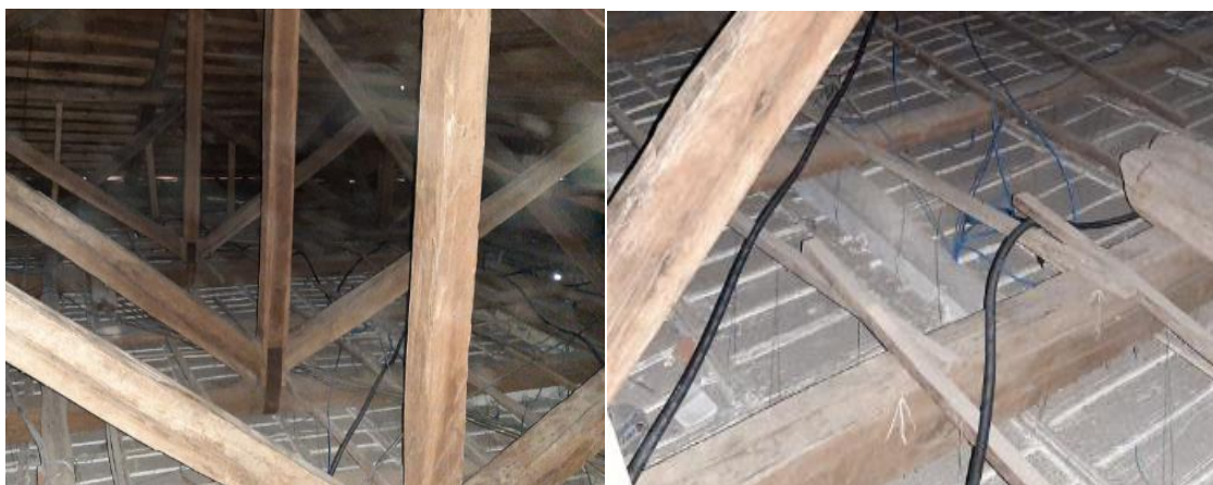
Figura 3.14: Instalación de conductores edificio de la dirección ESFOT-EPN. Fuente: (Propia)
