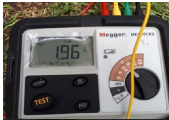
Figura 3.41: Lectura de medición de resistencia a tierra edificio de aulas ESFOT. Fuente: (Propia)
