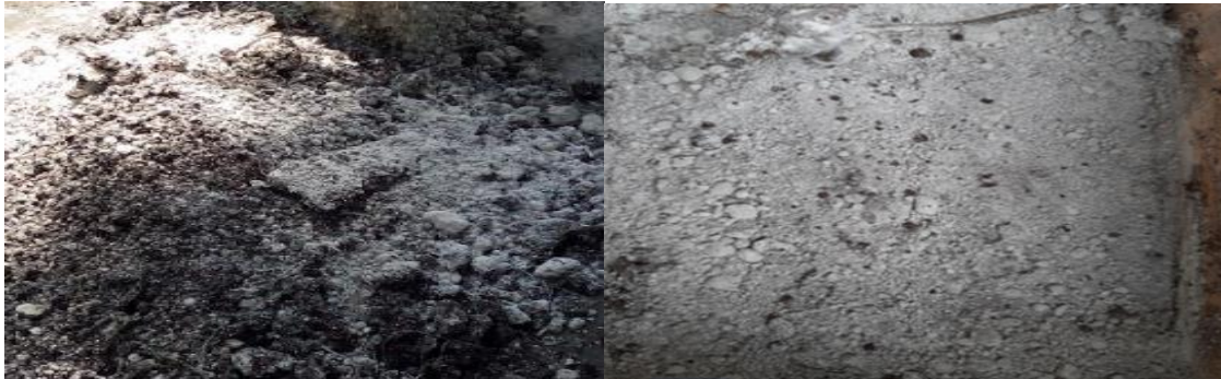
Figura 3.33: Compactación de terreno con el mejorador de suelo. Fuente: (Propia)
