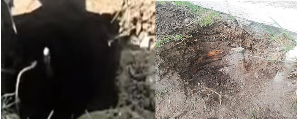
Figura 3.22: Excavación de la puesta a tierra. Fuente: (Propia)
