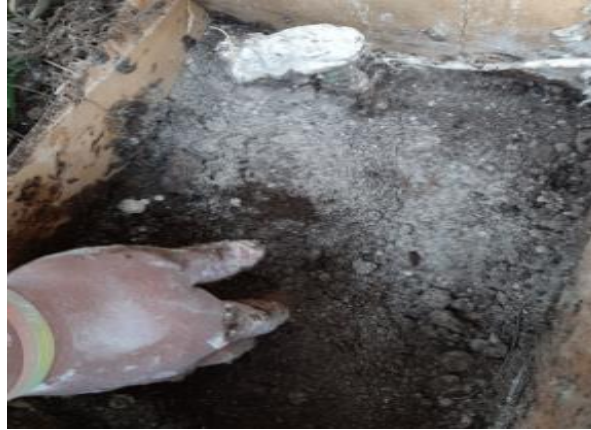
Figura 3.25: Relleno de la puesta a tierra Fuente: (Propia)
