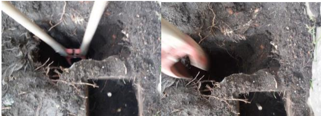
Figura 3.31: Excavación de pozo para la puesta a tierra.
