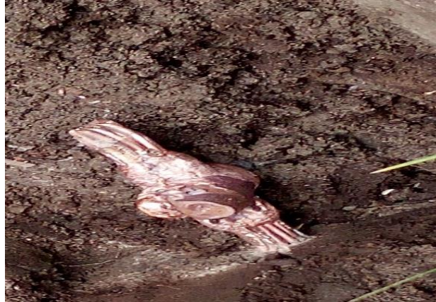
Figura 3.27: Unión mediante suelda exotérmica. Fuente: (Propia)
