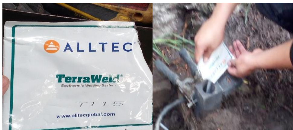
Figura 3.26: Molde de grafito y material fundente. Fuente: (Propia)
