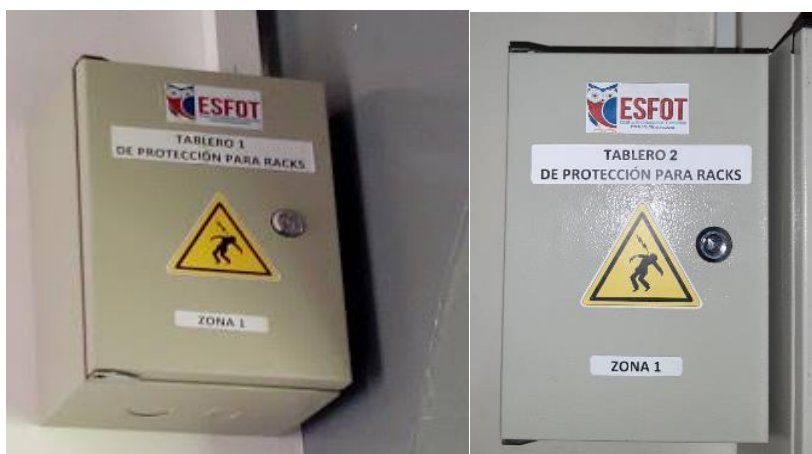
Figura 3.17: Instalación de tableros de protección. Fuente: (Propia)
