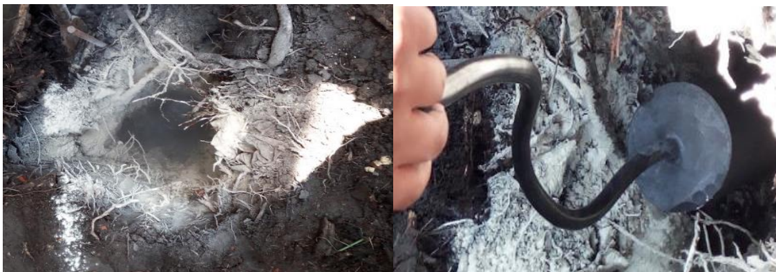
Figura 3.32: Instalación del electrodo de grafito.
