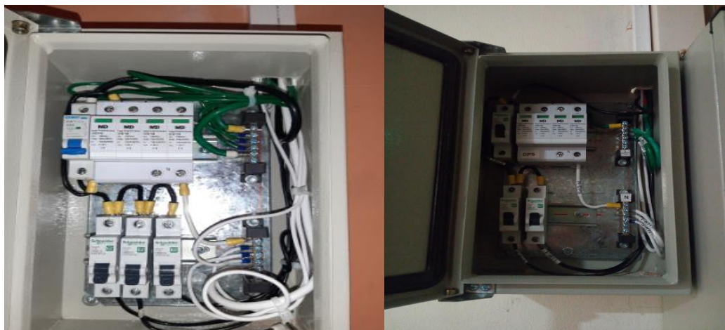
Figura 3.16: Construcción de tableros de protección Fuente: (Propia)
