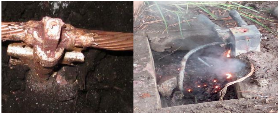
Figura 3.34: Soldadura exotérmica de puesta a tierra Fuente: (Propia)
