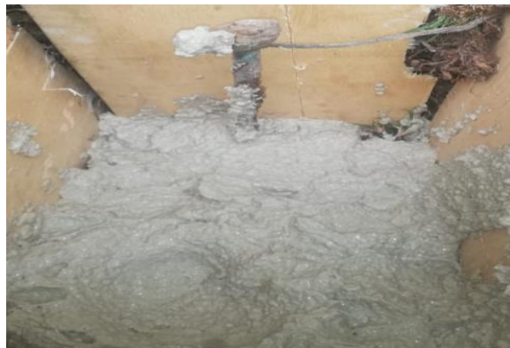
Figura 3.24: Vertido del mejorador de suelo Fuente: (Propia)
