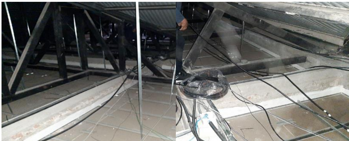
Figura 3.13: Instalación de conductores edificio de aulas ESFOT-EPN. Fuente: (Propia)
