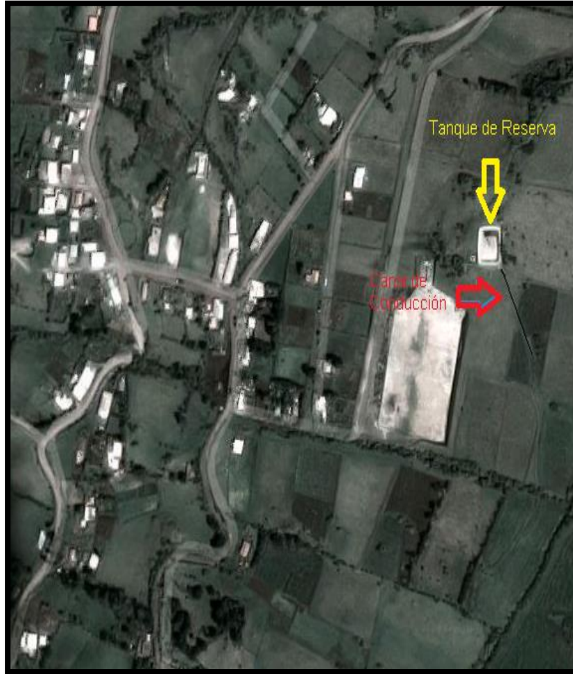
Figura 29. Ubicación del tanque de reserva y canal de conducción
