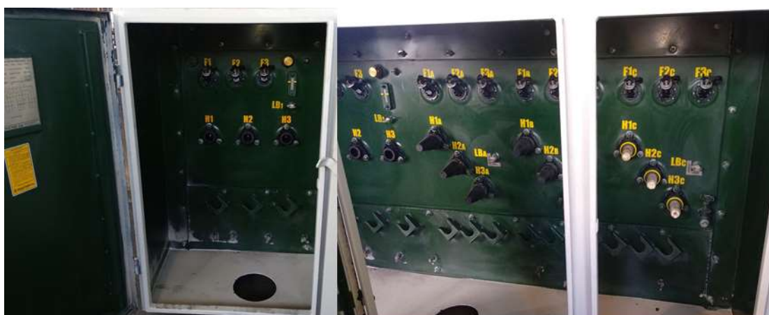
Figura 3.1. Caja de maniobras evaluada [Elaboración Propia].
