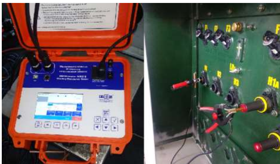
Figura 3.4. Medición de la resistencia de contactos de los seccionadores de la caja de maniobras [Elaboración propia].
