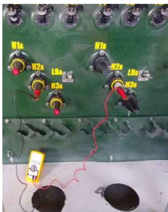
Figura 3.2. Medición de Continuidad en una caja de maniobras trifásica [Elaboración propia].
