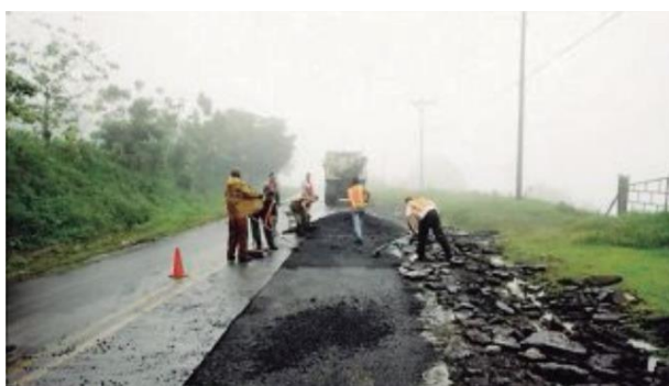
Figura 21. Bacheo profundo de pavimentos.
