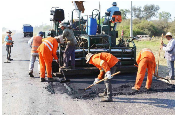
Figura 20. Bacheo superficial de pavimentos.
