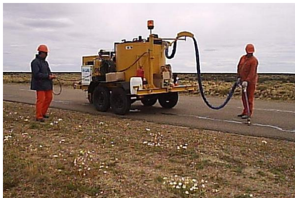
Figura 19. Sellado de pavimentos.
