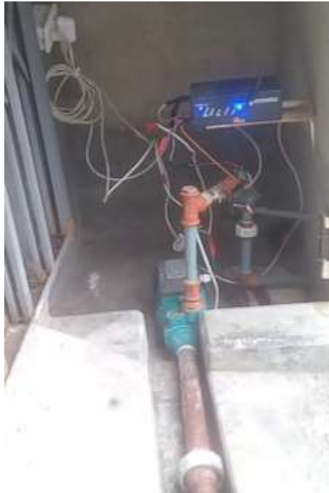
Figura 3.1 Instalación del prototipo
