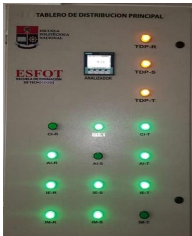
**Figura 3.40** Funcionamiento de las luces piloto.
