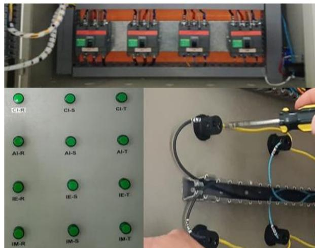
**Figura 3.23** Conexión de las luces piloto.
