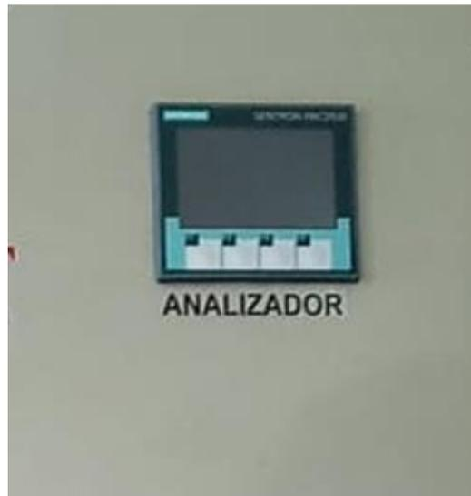
**Figura 3.32** Analizador de red montado en el panel.
