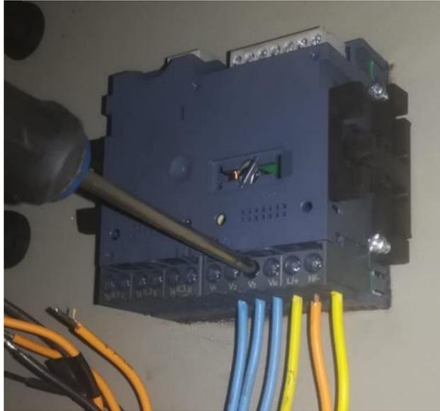
**Figura 3.36** Conexión del voltaje de medición.
