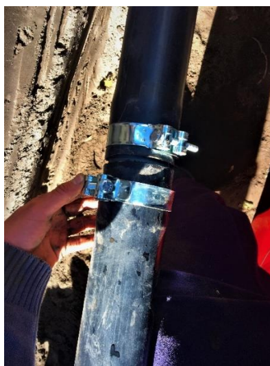
Figura 3.21 Unión de los terminales de las mangueras (Fuente Propia)
