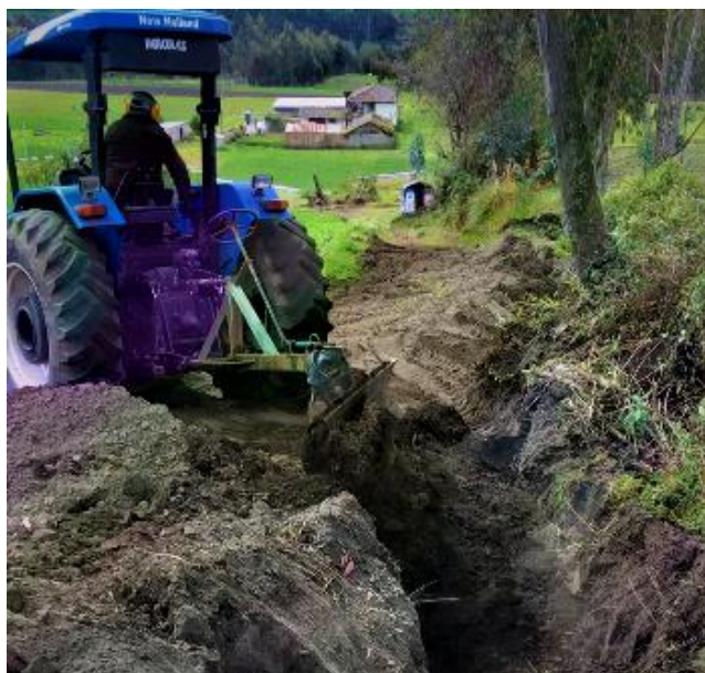
Figura 3.23 Relleno del canal de tierra (Fuente Propia)
