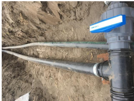
Figura 3.27 Soterramiento de tuberías para toma de conexión 3 (Fuente Propia)
