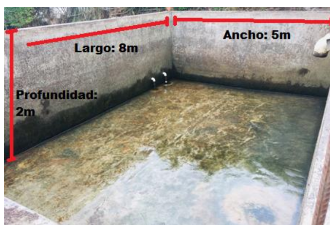
Figura 3.3 Estado y dimensiones del tanque reservorio (Fuente Propia)
