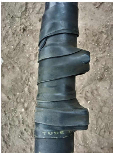
Figura 3.22 Protección contra la corrosión de abrazaderas (Fuente Propia)
