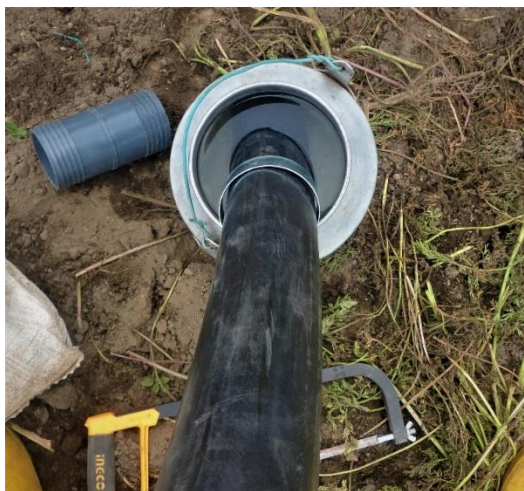
Figura 3.20 Calentamiento de terminales de mangueras (Fuente Propia)
