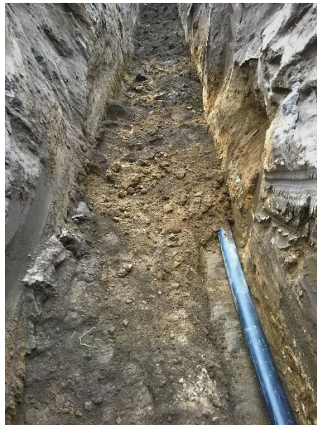
Figura 3.19 Colocación de la tubería de 3 (pulg) (Fuente Propia)
