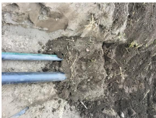
Figura 3.29 Soterramiento de tuberías para toma de conexión 1 (Fuente Propia)
