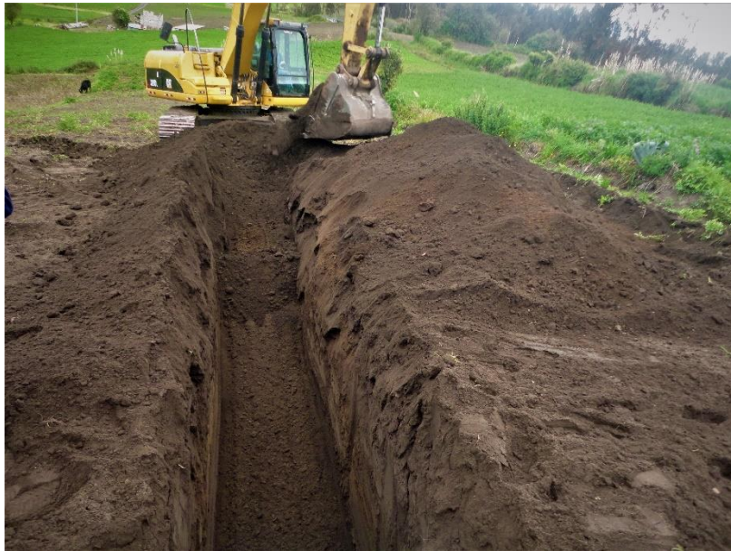
Figura 3.18 Excavación para tuberías fijas (Fuente Propia)
