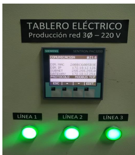
Figura 2.76. Menú “Comunicación” del Sentron PAC3200
