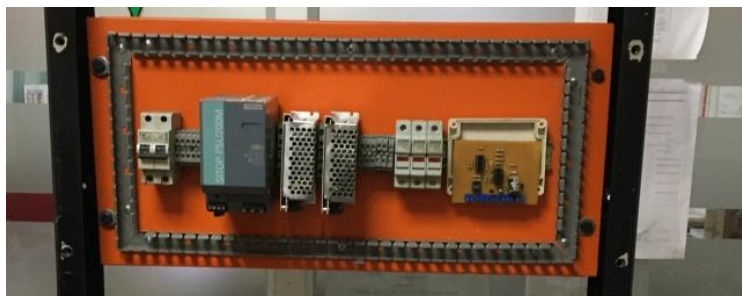
Figura 2.164. Instalación de fuentes de alimentación, elementos de seccionamiento, protección y placa electrónica
