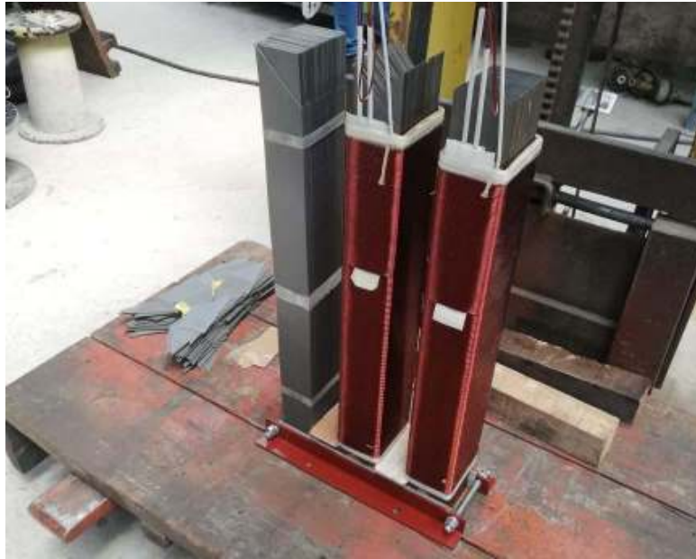
Figura 3.12 Montaje de los devanados en el núcleo
