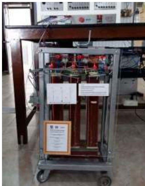
Figura 3.18 Adecuación final del autotransformador
