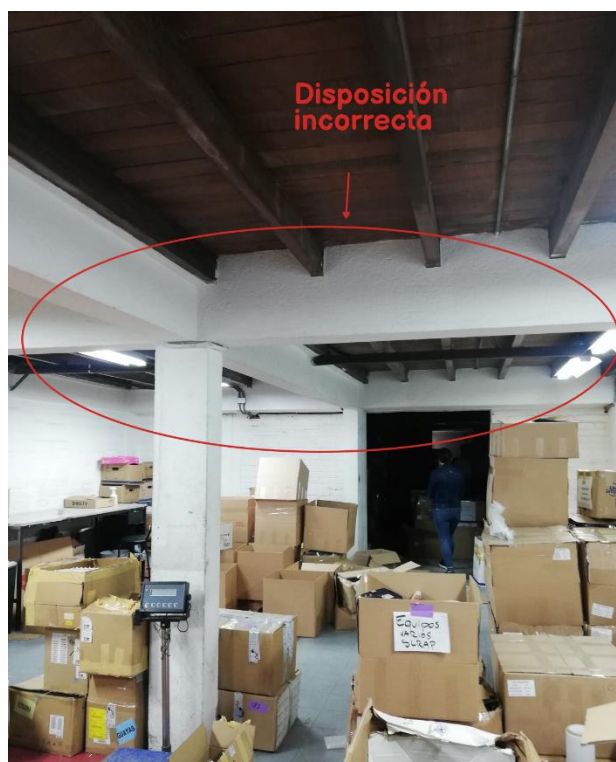
Figura 3.19. Iluminación bodega CNT parte 1
