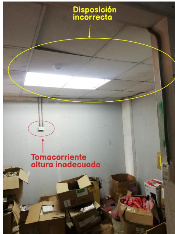
Figura 3.20. Iluminación bodega CNT parte 2
