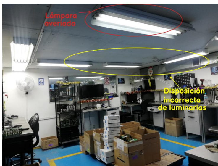
Figura 3.26. Iluminación área de control de calidad DIRECTV
