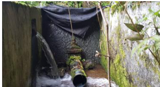
Figura 8. Estanque de la obra de captación
