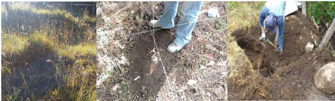
Figura 4. Limpieza del terreno y excavación de pozos Elaborado por: Caiza & Criollo (2021)
