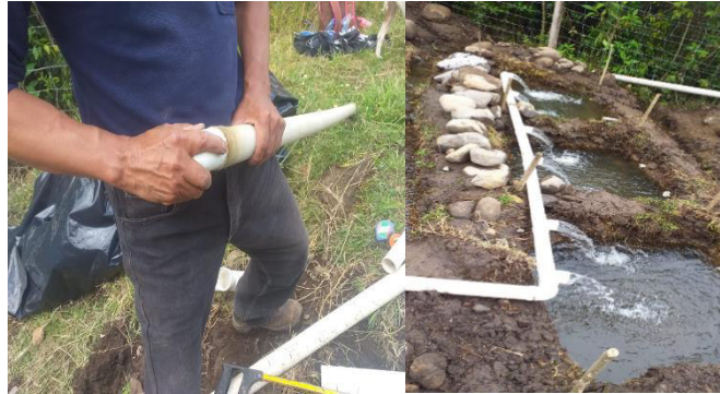
Figura 6. Instalación de tubería PVC Elaborado por: Caiza & Criollo (2021)
