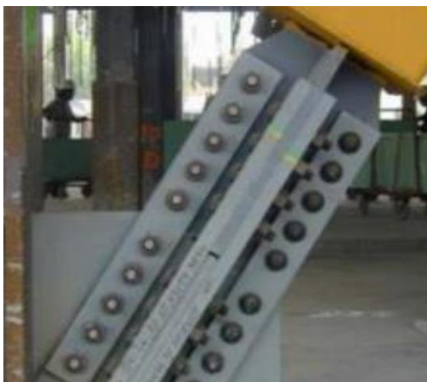
Figura 2.5.4 Conexión apemada
