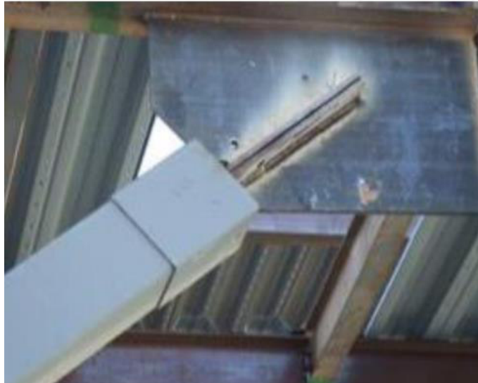
Figura 2.5.6 Conexión soldada
