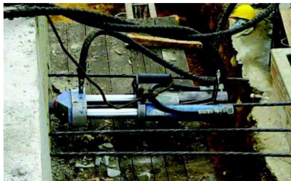
Figura 2.1.4 Tensado de cables
