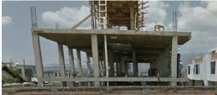
Figura 2-6 Construcción con vigas banda
