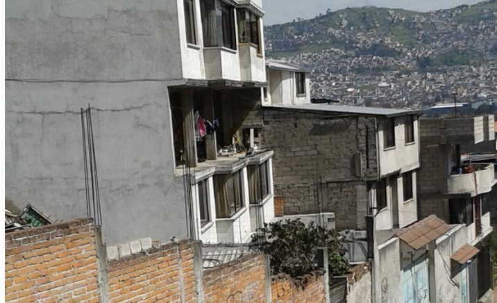
Figura 2-8 Construcción con Piso Blando Quito
