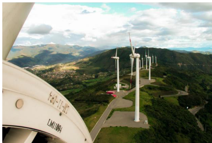
Figura 2.8. Parque Eólico Villonaco [24]
