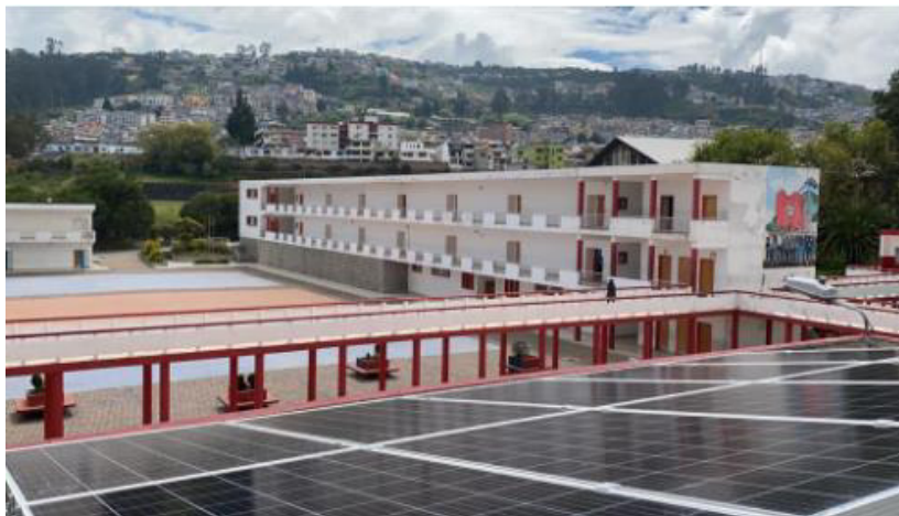
Figura 2.6. Paneles instalados en la Unidad Educativa Juan Pío Montúfar, en Quito [15]
