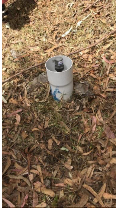
Ilustración 13 : Válvula de desagüe
