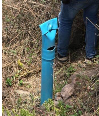
Ilustración 14: Válvula de aire
