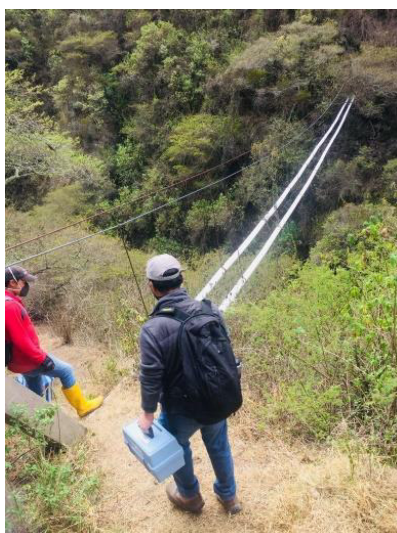
Ilustración 12: Tuberías de la conducción
