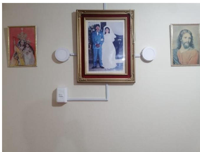
Figura 3.54 Circuito de iluminación del pasillo
