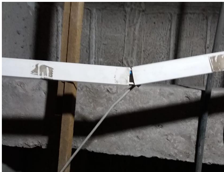
Figura 3.10 Derivación del cable desde una canaleta secundaria
