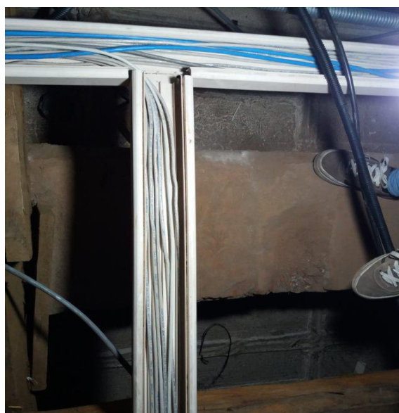
Figura 3.1 Canaletas principales
