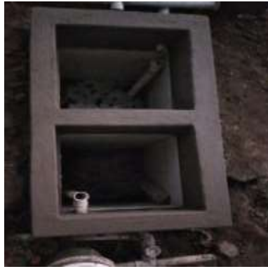
Figura 2.10 Trampa de grasas construida
