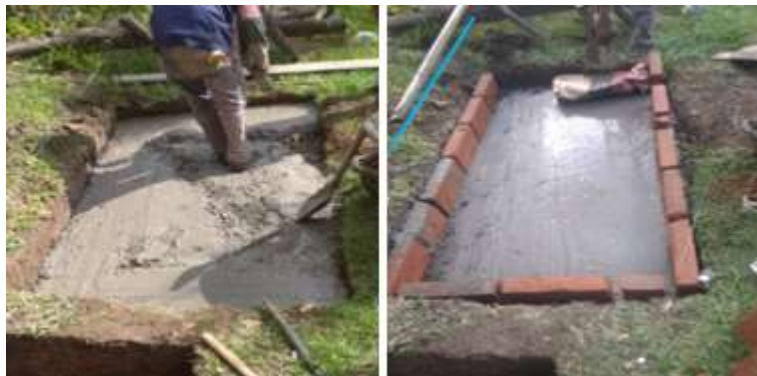
Figura 2.9 Cimentación del terreno y construcción
