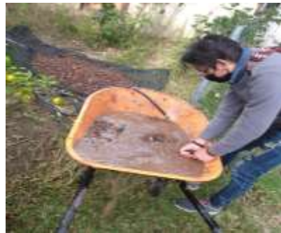
Figura 3.4 Lavado del material filtrante
