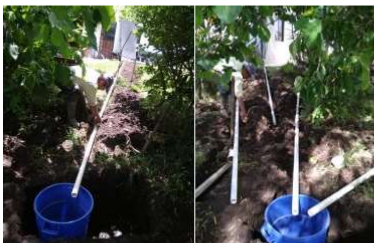
Figura 2.3 Aforo de caudales de las tuberías
