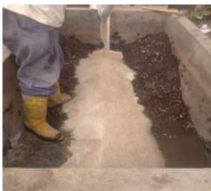
Figura 3.5 Colocación del material filtrante
