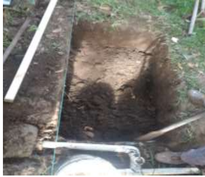
Figura 2.7 Excavación para la trampa de grasas
