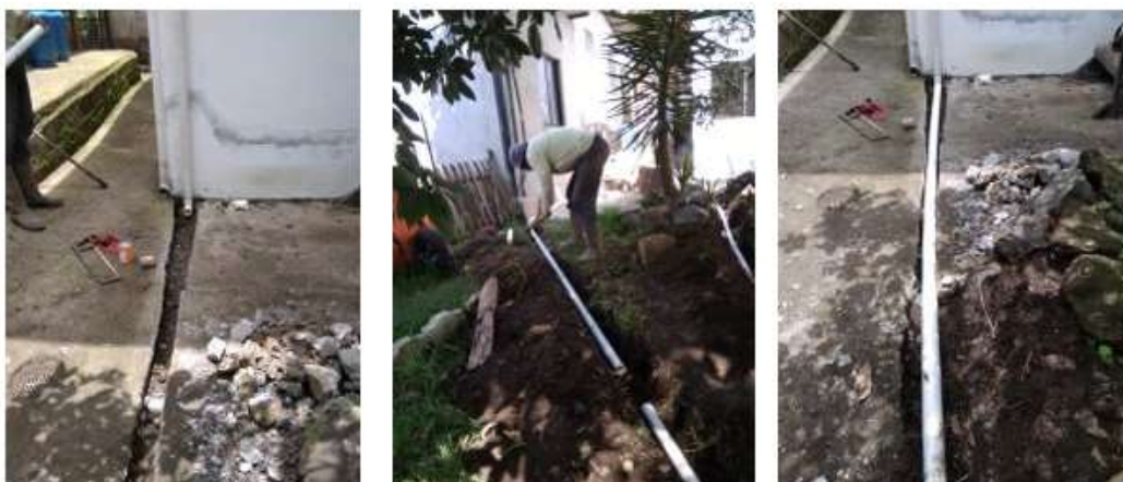
Figura 2.2 Separación de tuberías
