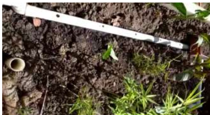
Figura 3.3 Tubería en la superficie del biofiltro
