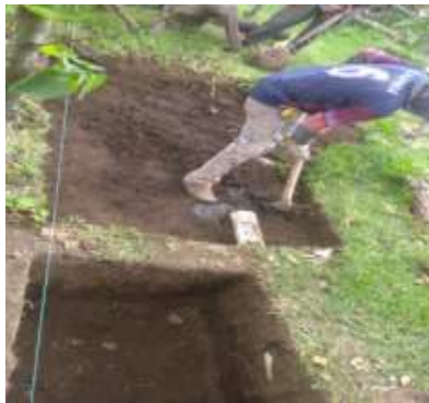
Figura 2.8 Excavación para el biofiltro
