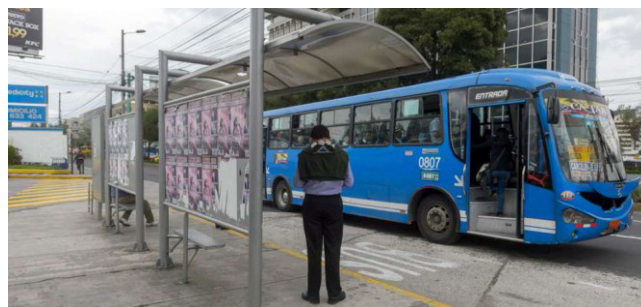
Figura 3.4 Parada de bus construida en acero [18]
