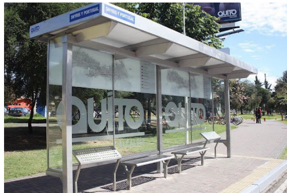
Figura 3.5 Parada de bus construida en acero inoxidable [19]
