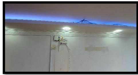
Figura 3.34 Colocación del Cable UTP
