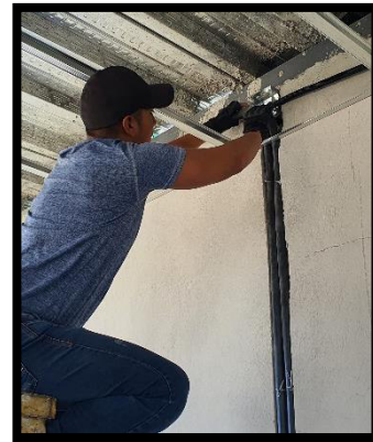
Figura 3.31 Instalación de cajas de paso
