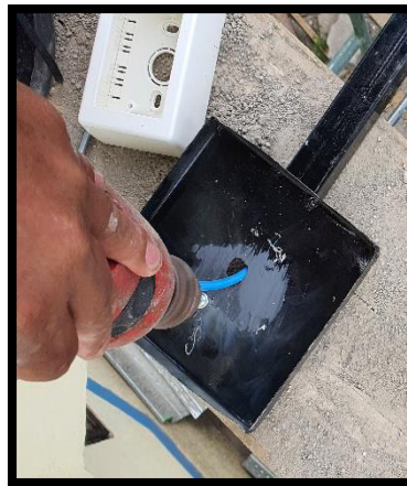
Figura 3.30 Taladrando la estructura de soporte
