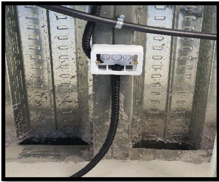
Figura 3.32 Terminado de la puesta de mangueras
