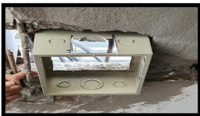
Figura 3.18 Colocación de la caja de paso
