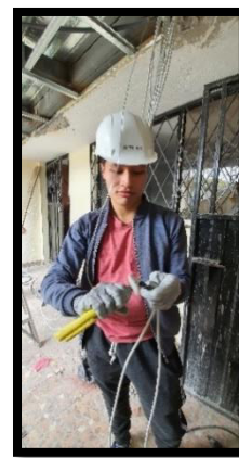
Figura 3.20 Unión de la guía con el cable UTP
