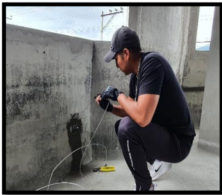
Figura 3.21 Colocación de la guía en la manguera
