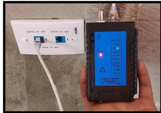
Figura 3.65 Tester en el face plate
