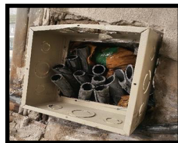
Figura 3.19 Sellado de la caja de paso con las 12 mangueras
