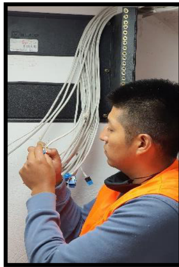
Figura 3.24 Colocación de jacks para colocarlos en el patch panel
