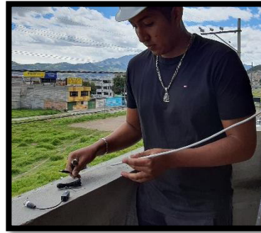
Figura 3.36 Colocación de baluns y empalme del jack de la fuente de poder
