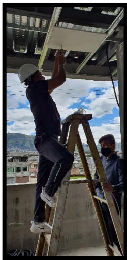
Figura 3.29 Realización de las aberturas
