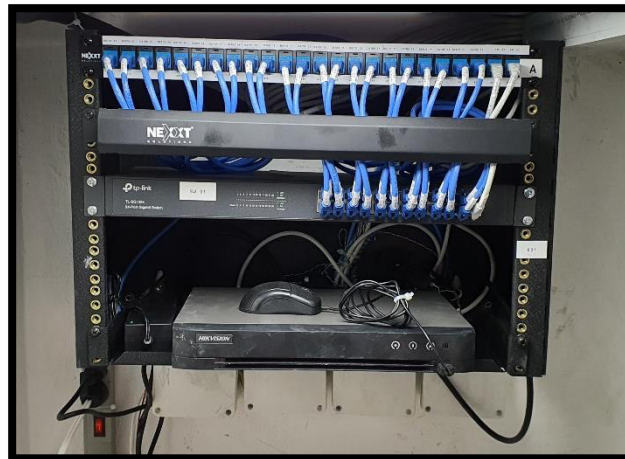
Figura 3.39 Terminación de la instalación física del CCTV
