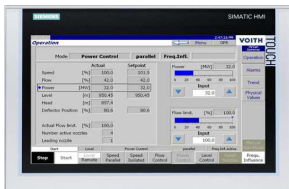
Figura 1.29. Panel de control siemens
