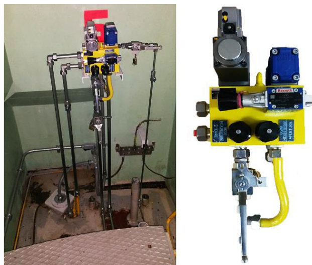
Figura 1.23. Válvula control para cada inyector
