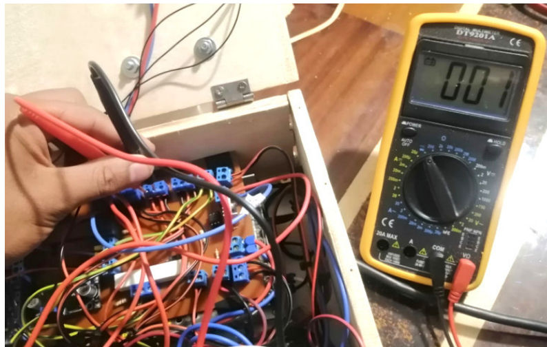
Figura 3.29 Prueba de continuidad con el multímetro
