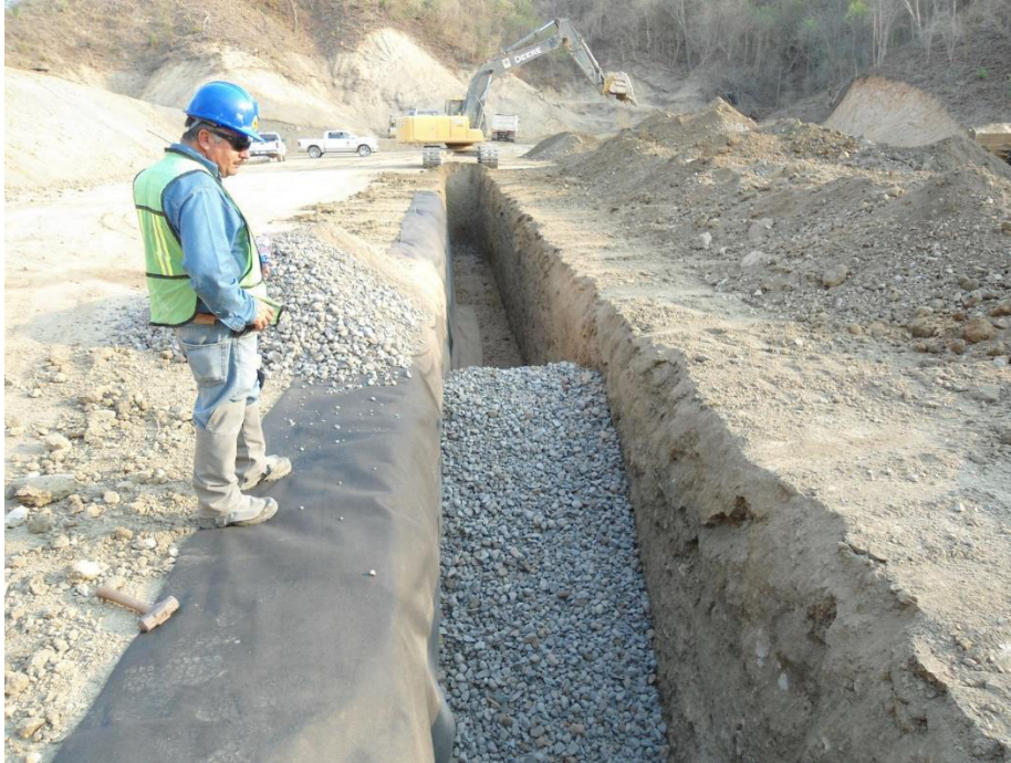
Figura 120. Construcción del sistema de subdrenaje
