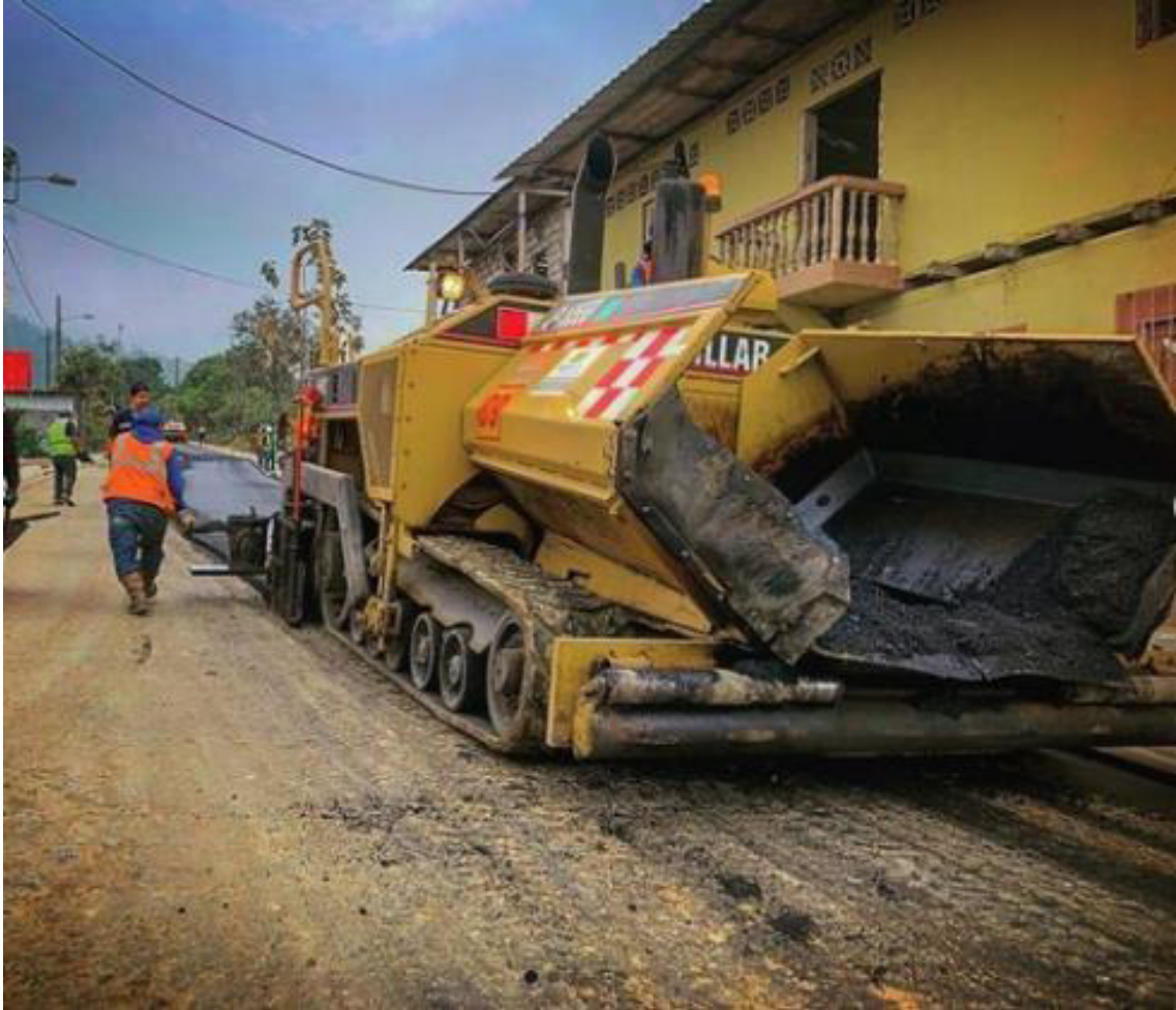
Figura 123. Tendido de carpeta asfáltica
