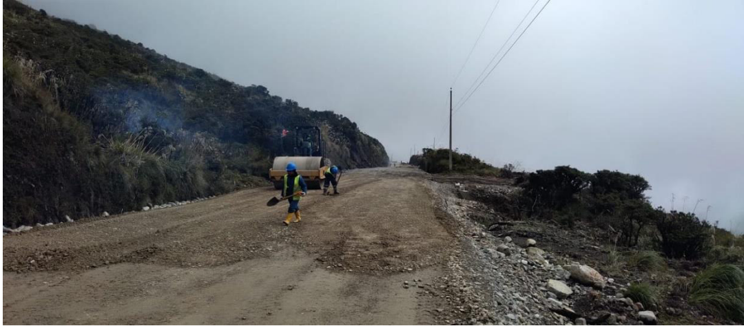
Figura 119. Acabado de obra básica
