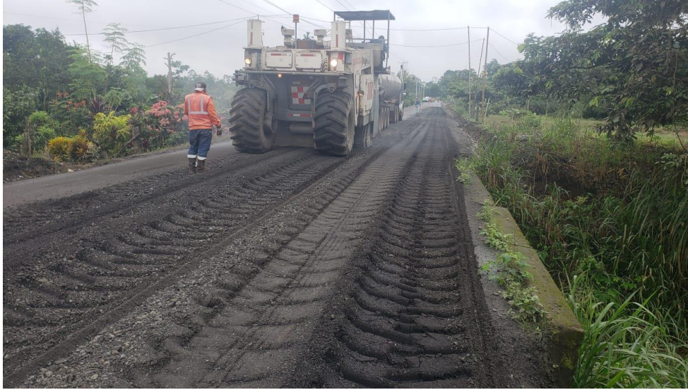
Figura 128. Reciclado de base estabilizada con emulsión asfáltica
