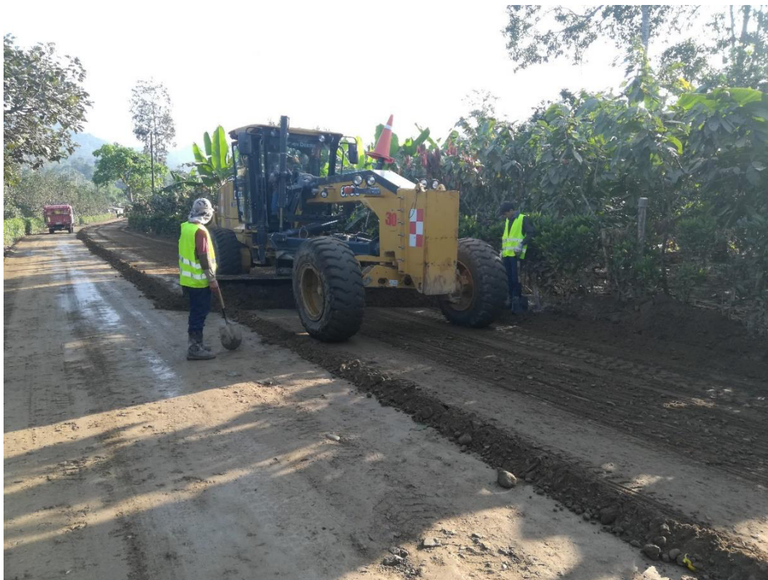
Figura 121. Tendido de material pétreo
