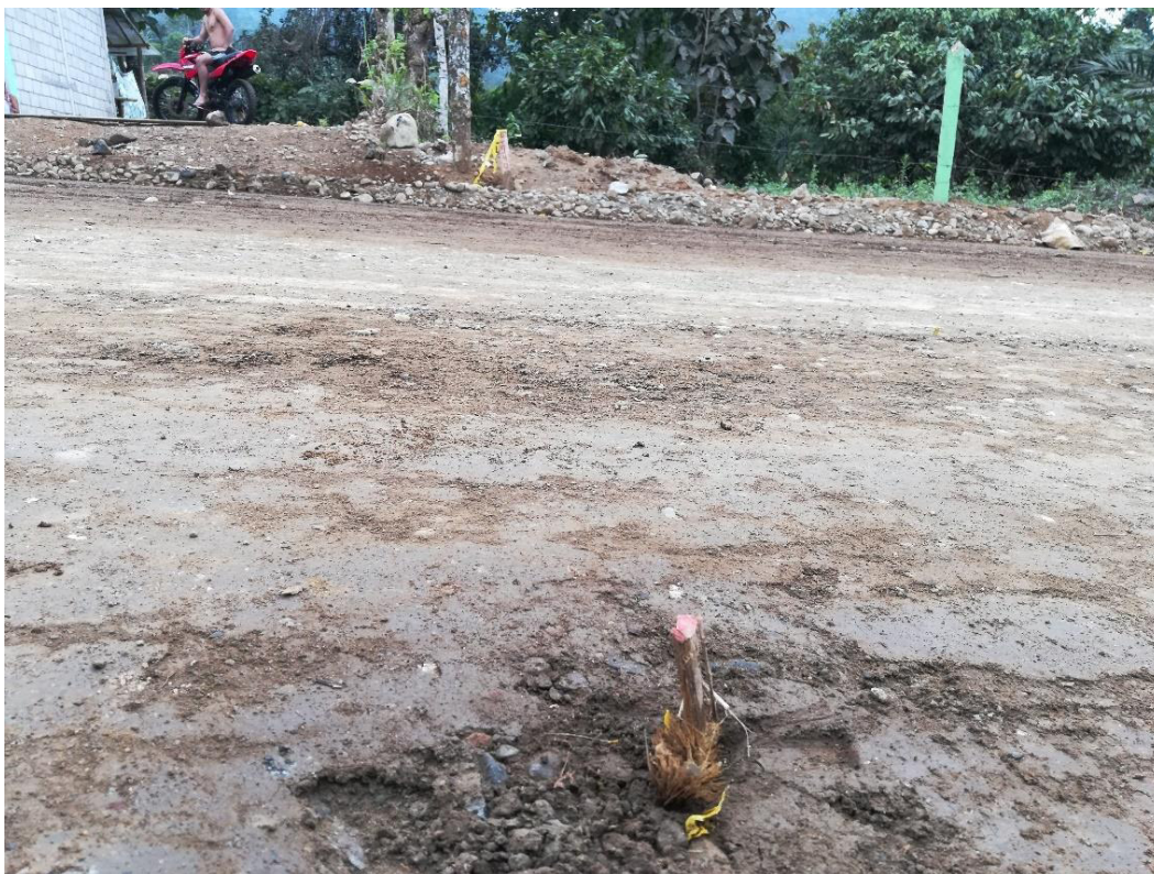
Figura 118. Replanteo y nivelación vial
