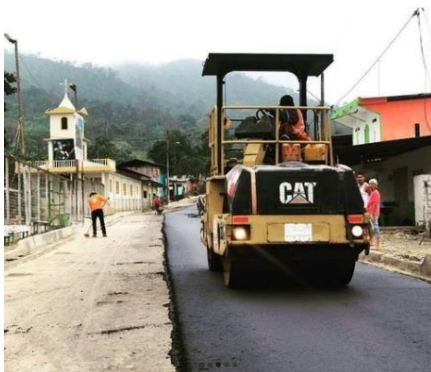
Figura 2. Compactación de la capa de rodadura de un pavimento flexible
