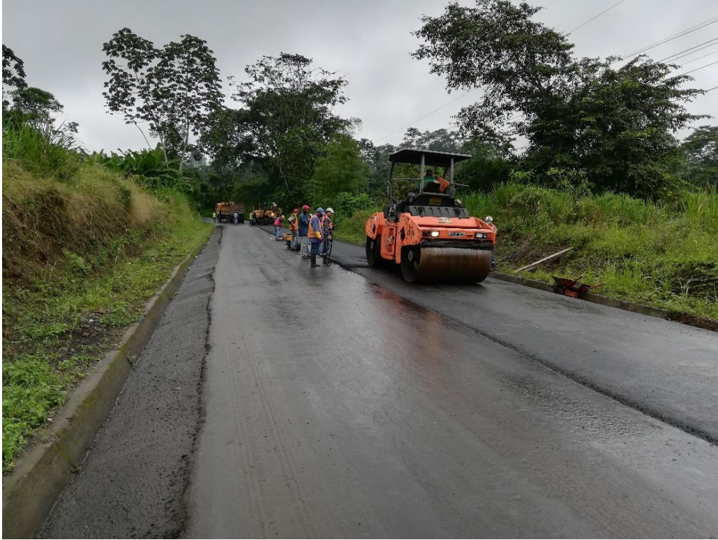
Figura 127. Compactación de carpeta asfáltica
