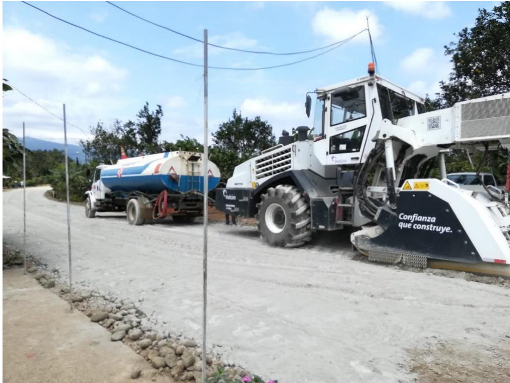
Figura 5. Estabilización con cemento
