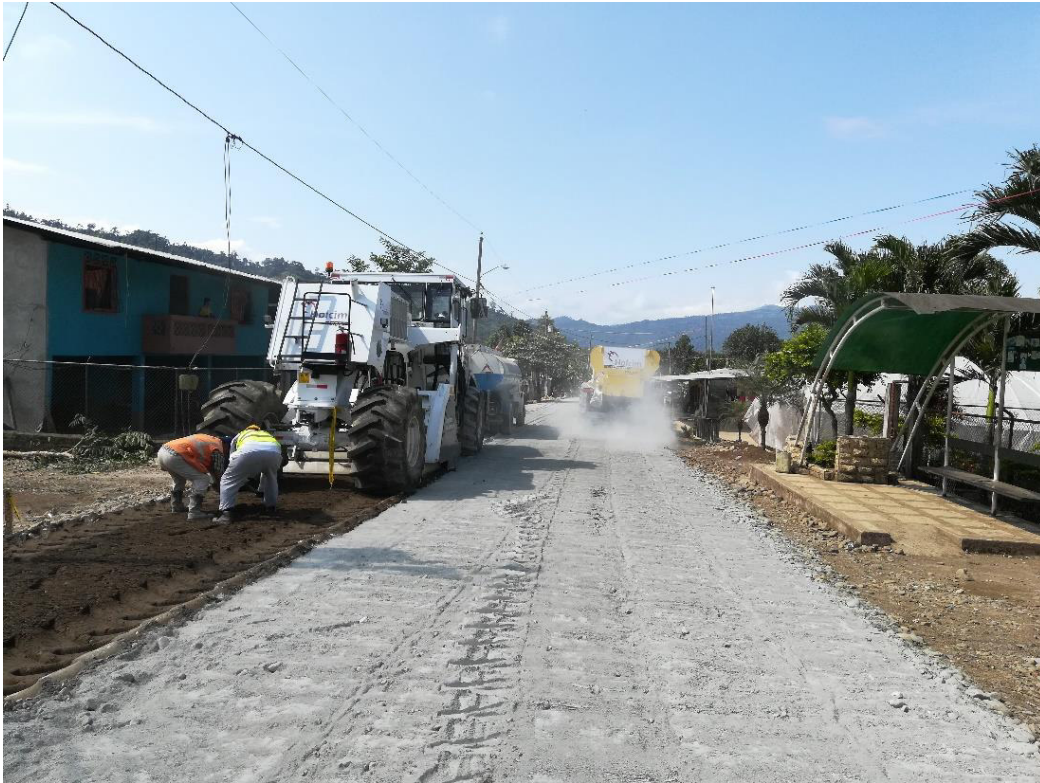
Figura 125. Reciclado de base estabilizada con cemento
