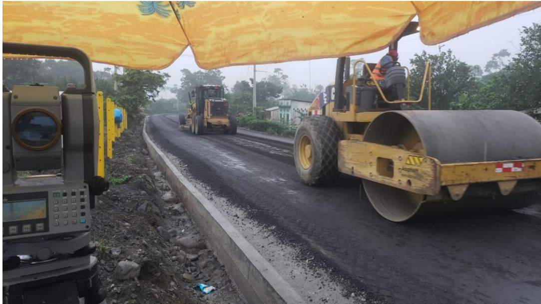
Figura 129. Compactación y sellado de capa de base estabilizada con emulsión asfáltica
