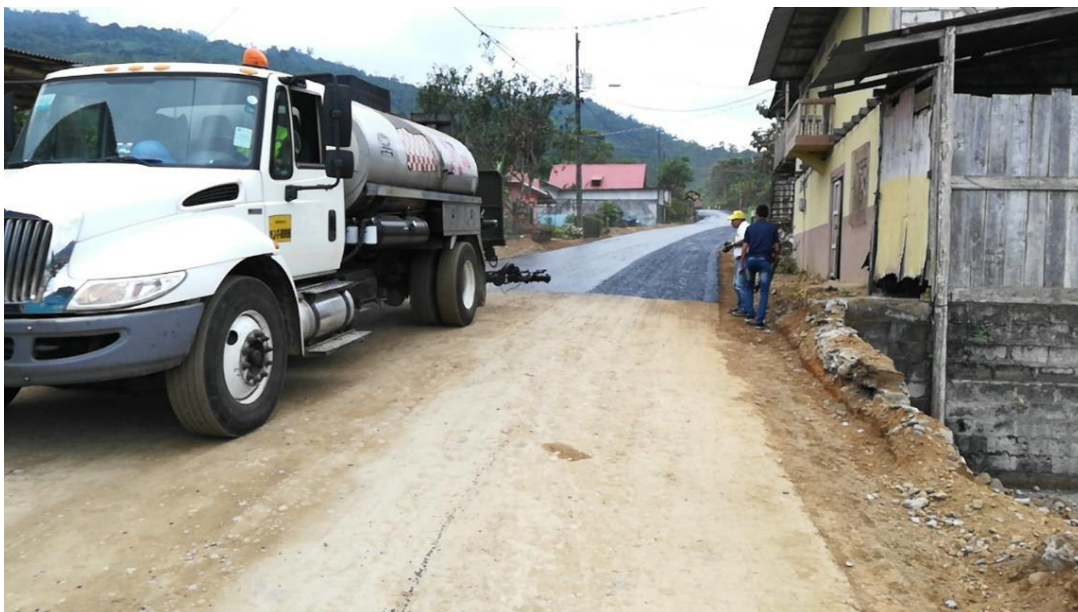
Figura 122. Riego de imprimación
