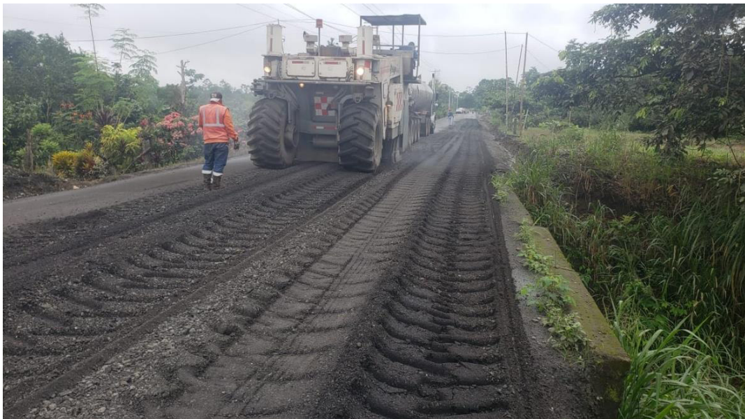
Figura 6. Estabilización con emulsión asfáltica
