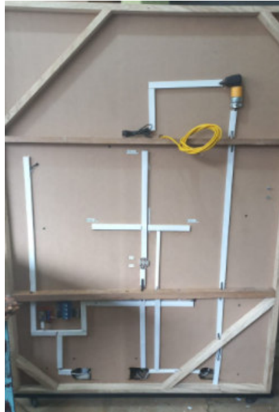
Figura 3.37 Conexiones de dispositivos en la parte posterior del módulo
