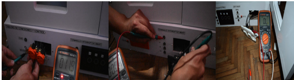
Figura 3.80 Prueba de conexiones eléctricas
