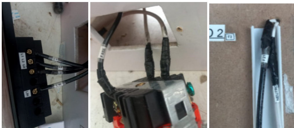
Figura 3.33 Identificación de cables y terminales de los dispositivos
