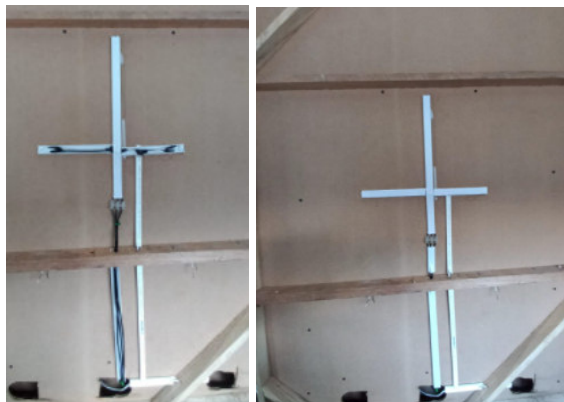
Figura 3.32 Organización de cables y colocación de canaletas
