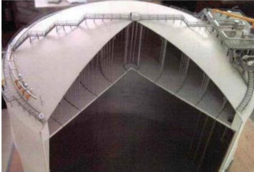
Figura 2.18. Representación en corte del techo colgante de aluminio.
