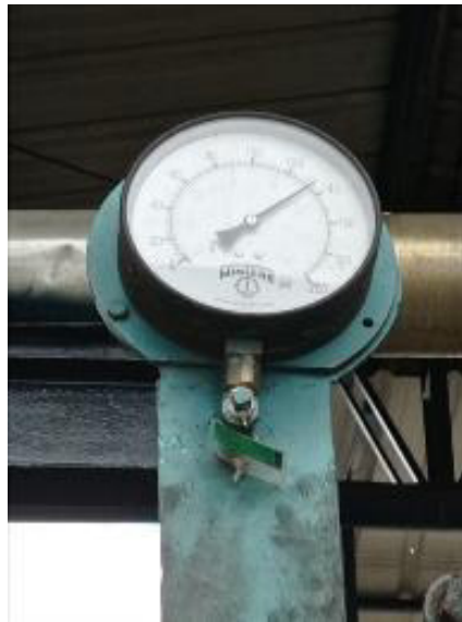
Figura 2.14. Dial de manómetro en la línea de salida de vapor . (fuente: propia)
