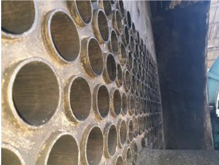
Figura 2.13. Espejo frontal, tubos expandidos. (fuente: Reylacteos C.L. "Mantenimiento anual 2020")
