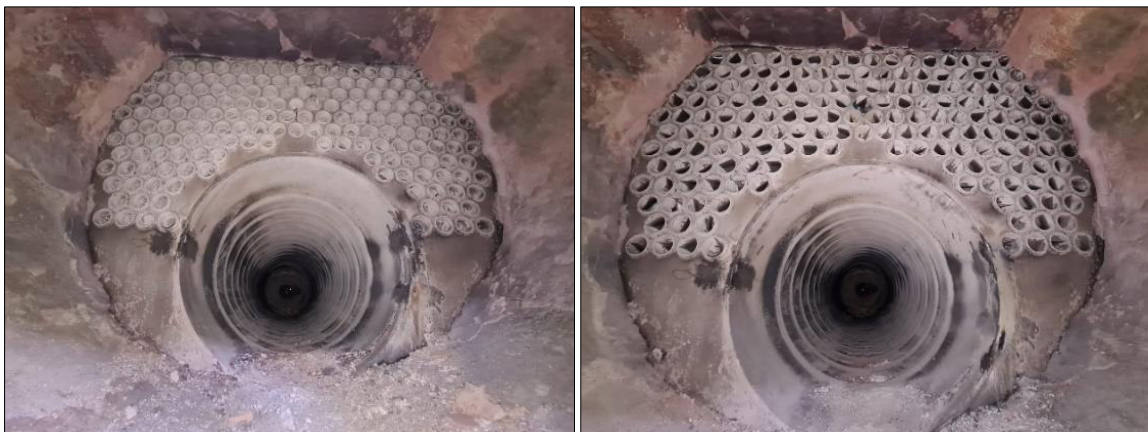
Figura 2.24. Montaje de los 176 turbaldores de cinta helicoidal retorcida. (fuente: propia)
