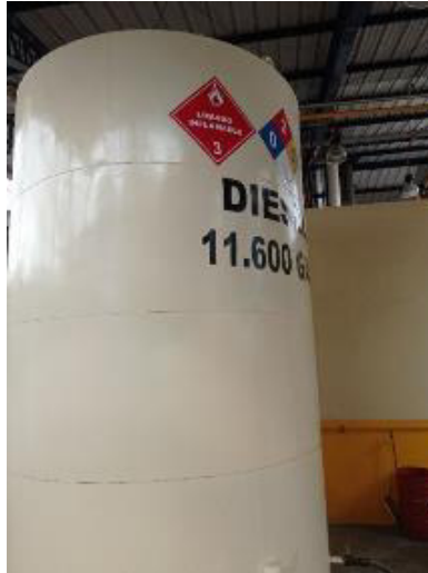
Figura 2.9. Tanque nodriza de 11600 galones. (fuente: propia)
