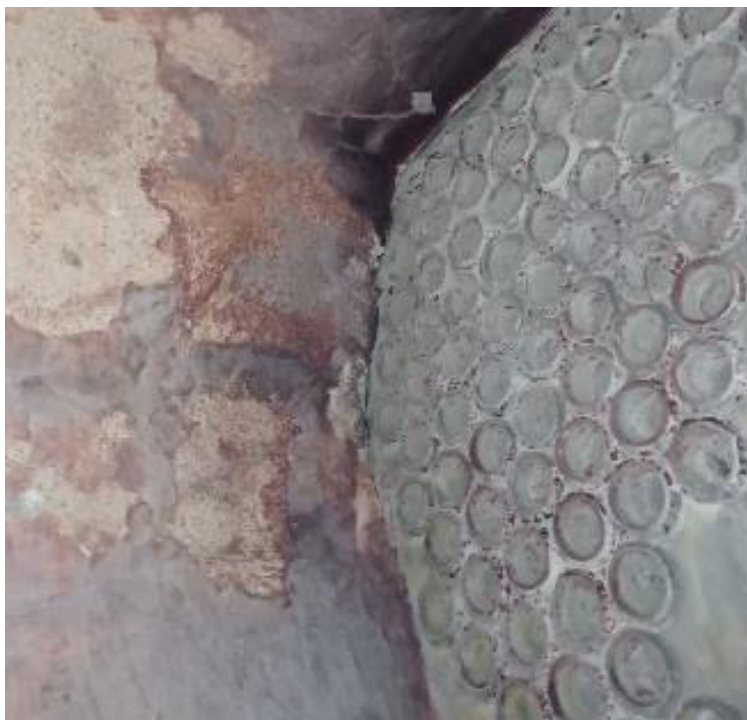
Figura 2.12. Espejo posterior, tubos soldados. (fuente: Reylacteos C.L. "Mantenimiento anual 2020")
