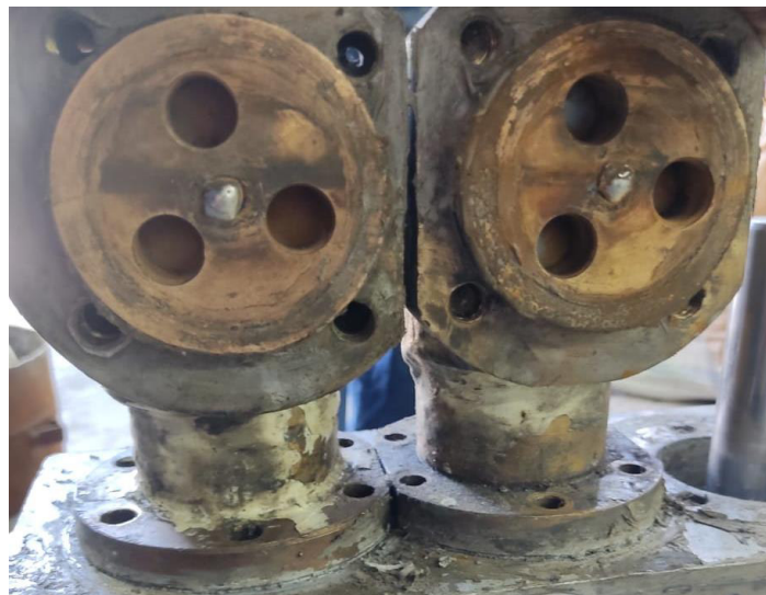
Figura 1. Cámaras de compresión con sellador. [Fuente propia]
