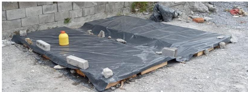
Figura 53. Curado de losas
