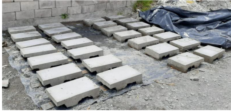
Figura 54. Losas desencofradas
