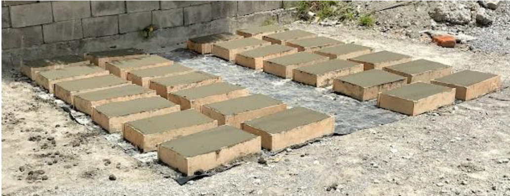
Figura 47. Probetas después de la fundición
