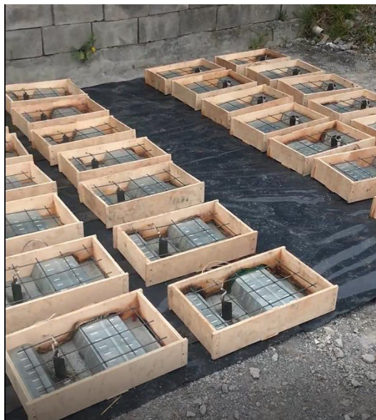
Figura 43. Probetas previo a la fundición de las losas
