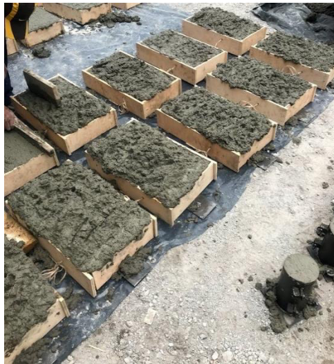
Figura 46. Fundición de losas
