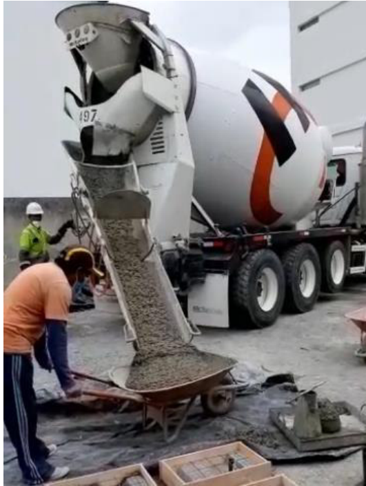
Figura 45. Descarga de hormigón
