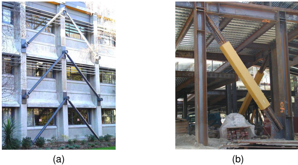
Figura 2.8. (a) Estructura con riostra de acero convencional (b) estructura con riostras BRB.
