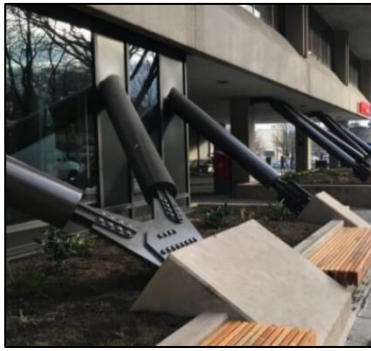
(a) conexión emperrada estandar.
