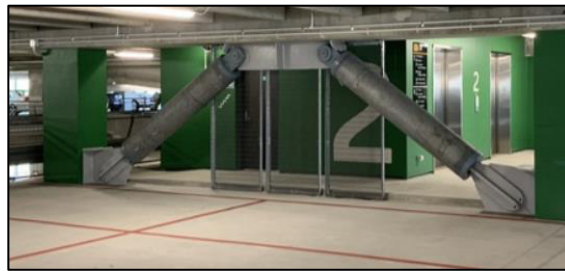
(c) una conexión articulada con pasador
