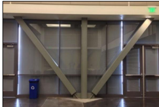
(b) conexión soldada.
