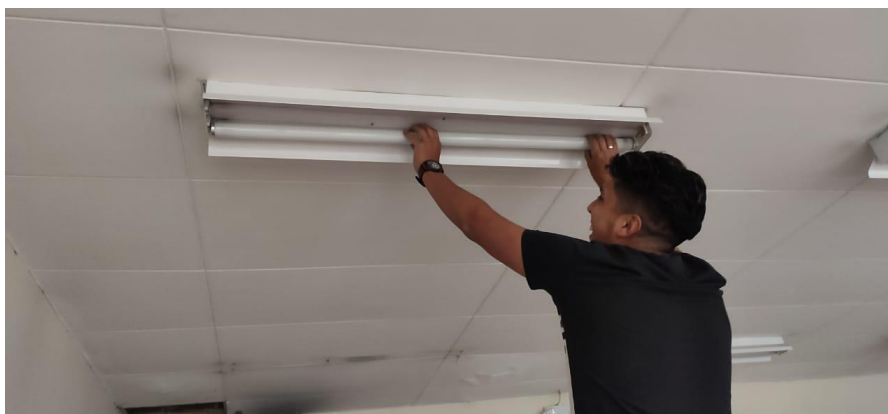
Figura 3.13. Colocación de las luminarias LED.
