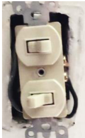
Figura 3.13 Interruptor obsoleto
