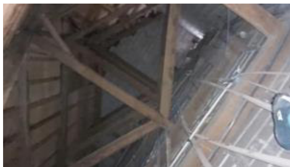
Figura 3.2. Parte superior del techo.
