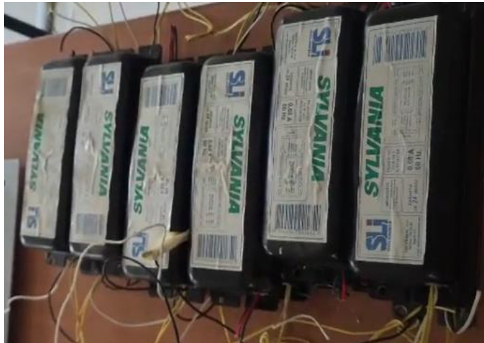
Figura 3.12. Balastos retirados de las lámparas.
