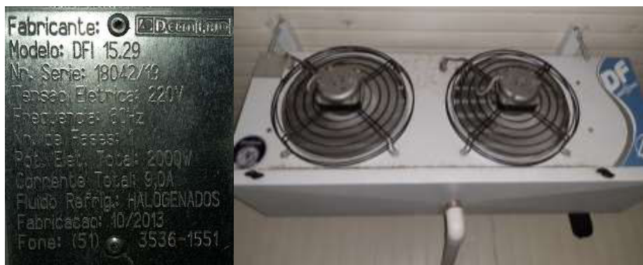
Figura 3-16 Evaporador de cámara frigorífica
