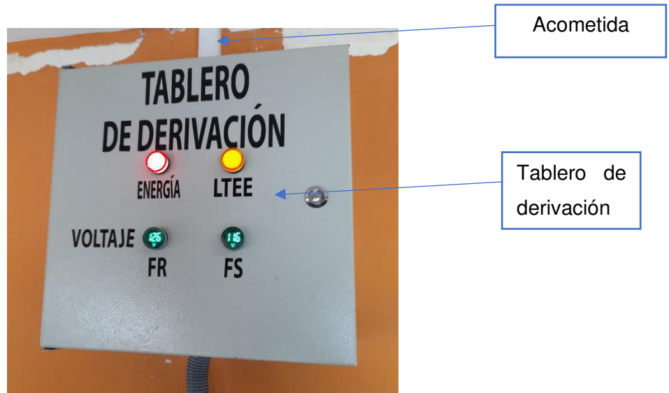
Figura 3.1 Tablero de derivación
