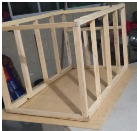
Figura 3.48 Colocación de las paredes en la base del invernadero
