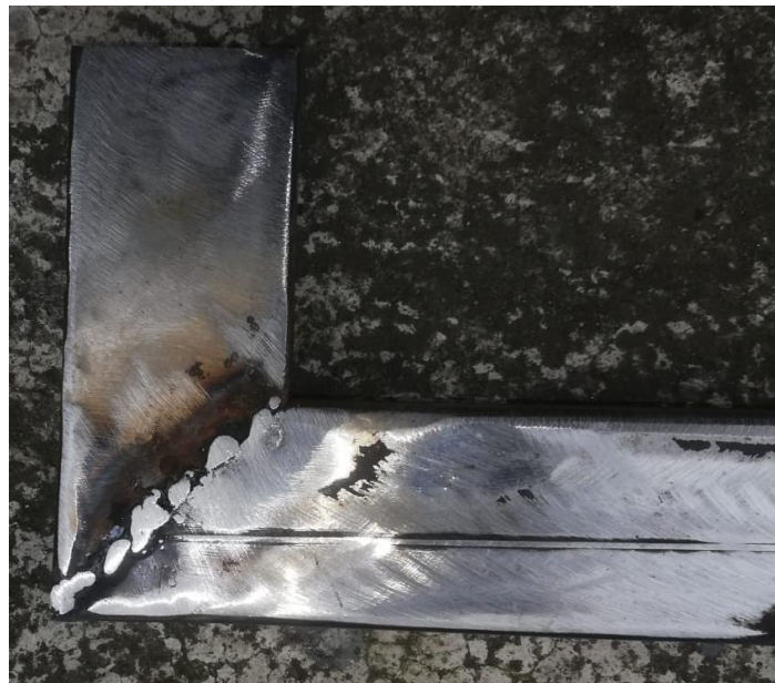
Figura 2.10 Cordón de soldadura entre bases metálicas pulidas.
