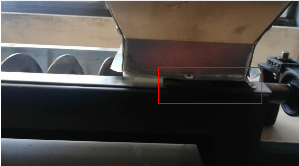
Figura 3.7 Separación entre tolva y base metálica.
