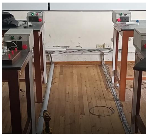
Figura 2.28 Cableado de las mesas al piso
