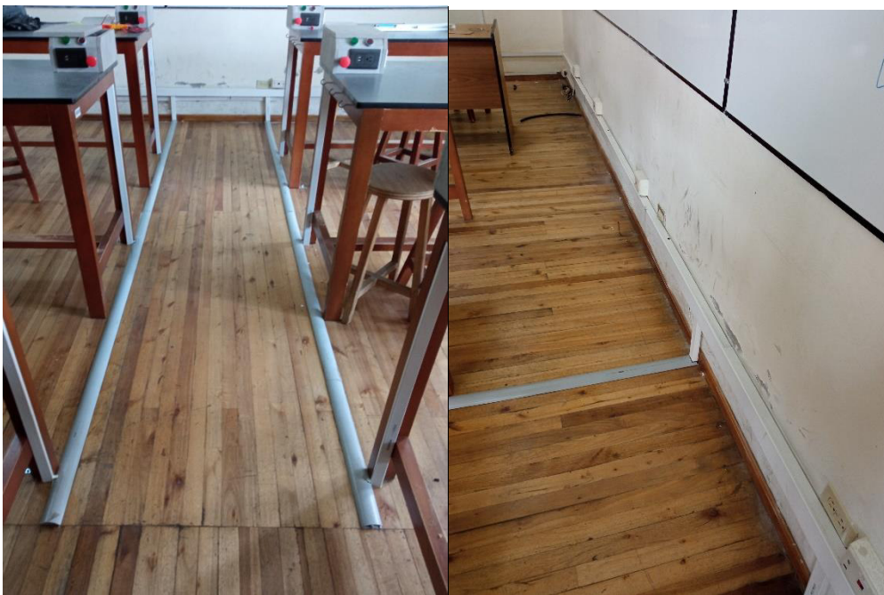
Figura 3.2 Componente entregable: canaletización.
