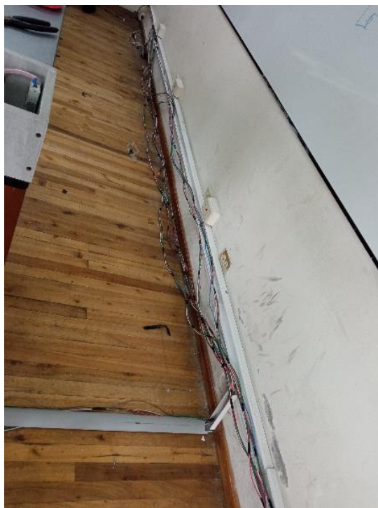
Figura 2.29: Cableado en las canaletas de pared
