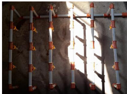
Figura 2.41 Estructura de riego. Fuente: (Propia)
