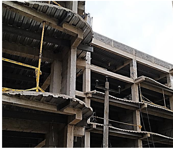
Figura 3. Estructura mixta ubicada en la ciudad de Quito.
