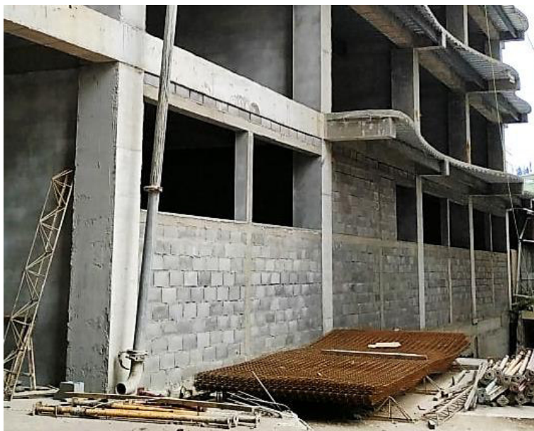
Figura 4. Sistema tradicional: mampostería de bloque.
