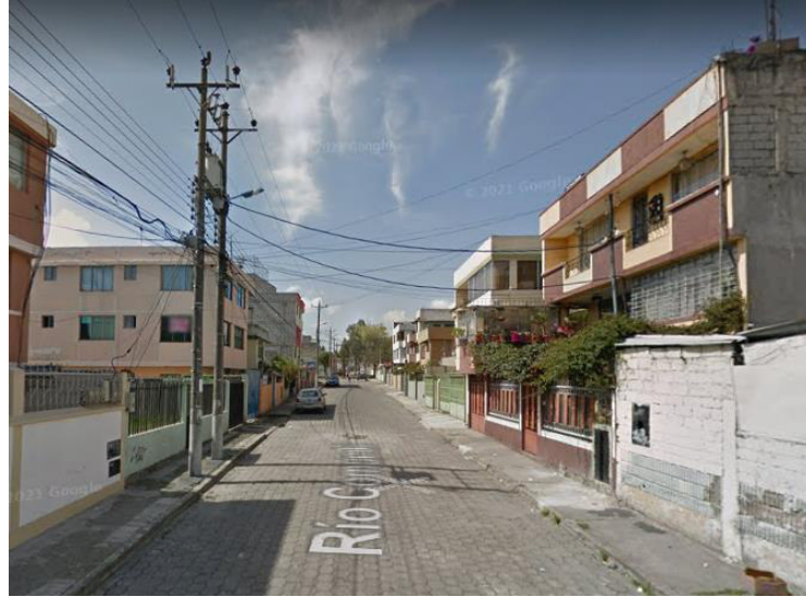
Figura 3.2. Imagen tomada de la zona residencial de la red 21C y el transformador N°15482
