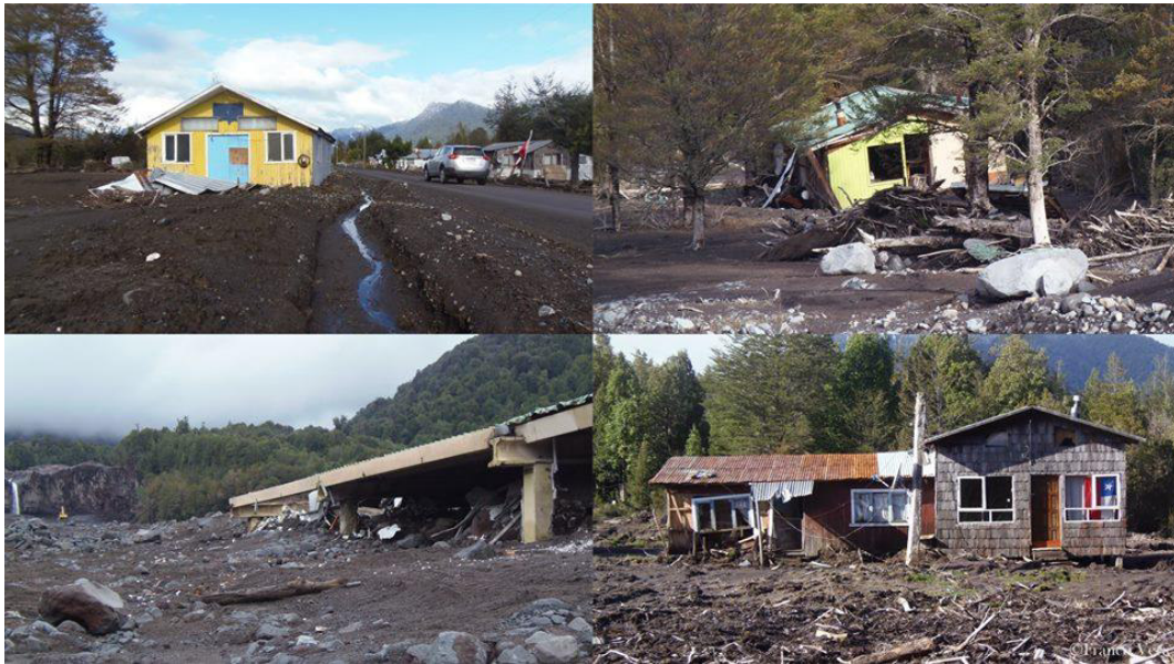
Figura 2.7. Infraestructura destruida por flujos laharios que descendieron hacia el sur del volcán Calbuco (Chile) en 2015. Tomado de Vera, 2018.
