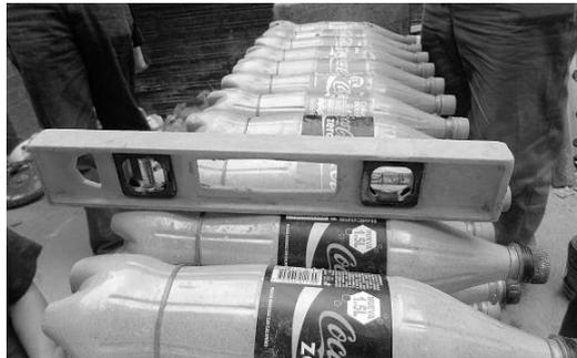
Figura 1.1. Construcción de un muro con botellas.
