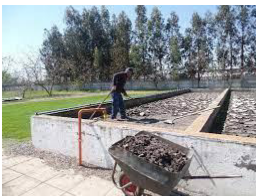
Figura 17. Lechos de secado de lodos
