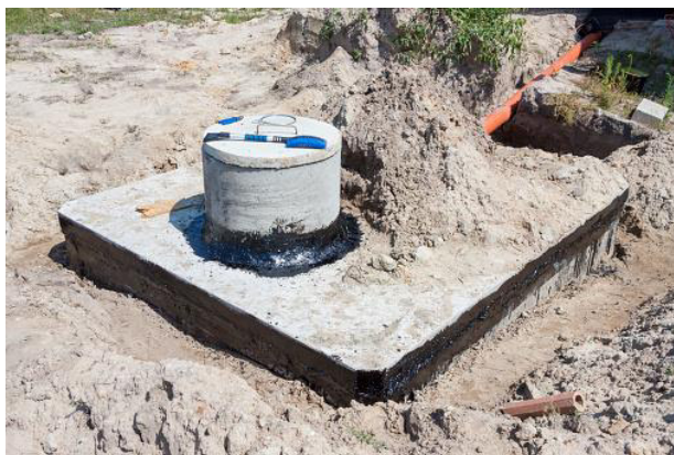
Figura 15. Construcción de un Tanque Séptico
