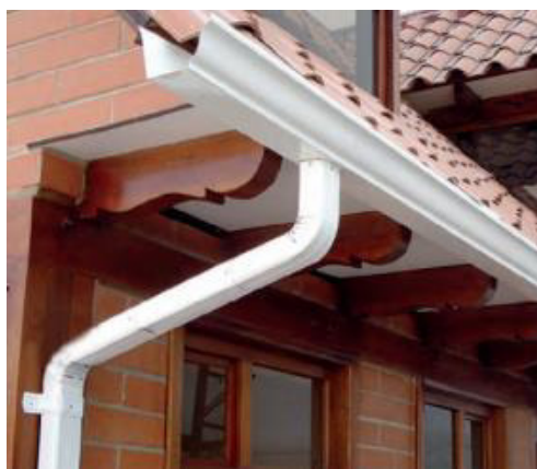
Figura 44. Canal residencial y bajante de agua lluvia
