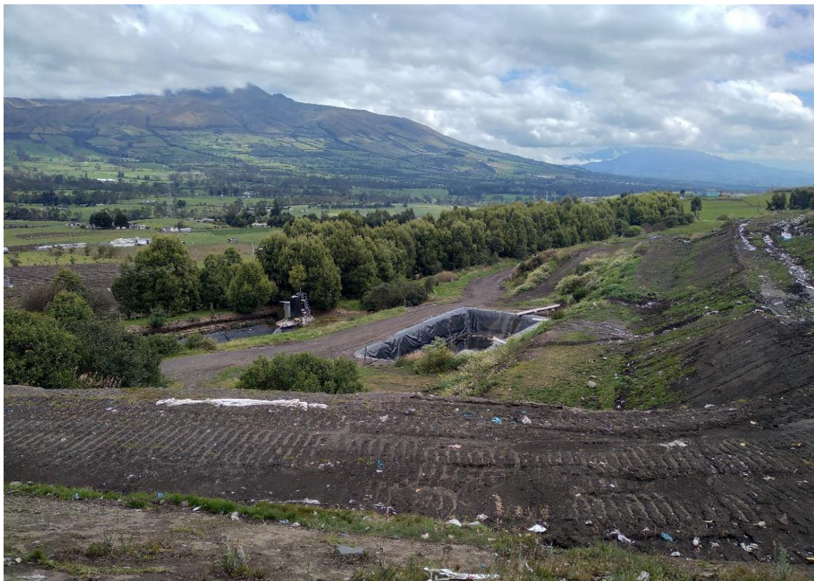
Figura 10. Vista panorámica de las piscinas de lixiviado
