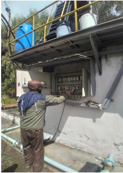
Figura 14. Caja de control de motor para agitación
